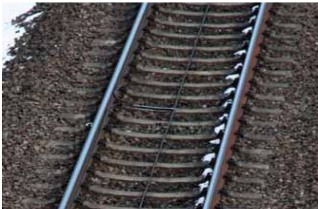
Abbildung 16 – LZB Antennenkabel im Gleis
