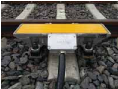
Abbildung 13: Gleismagnet für PZB
