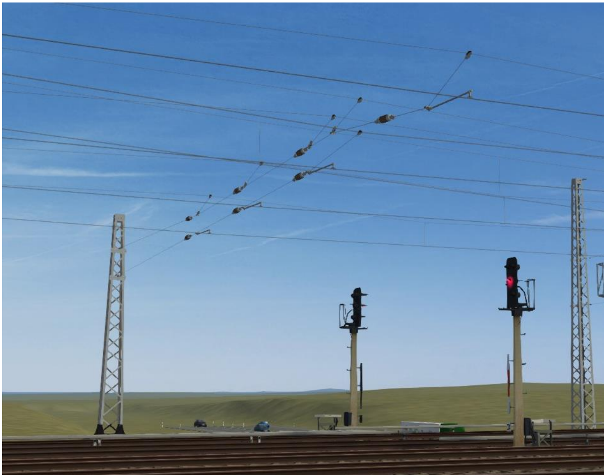
Abbildung 23 - Bogenabzug an der Greifswalder Straße in Berlin
