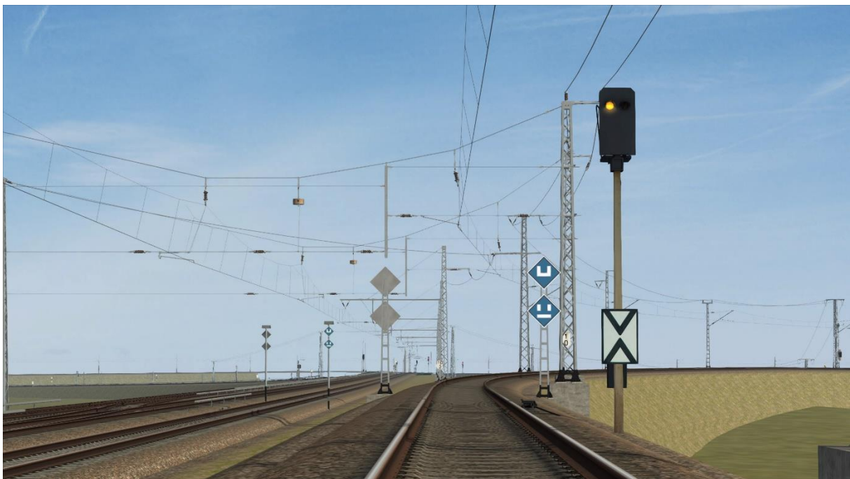
Abbildung 18 - verkürzte Schutzstrecke in einem Quertragwerk
