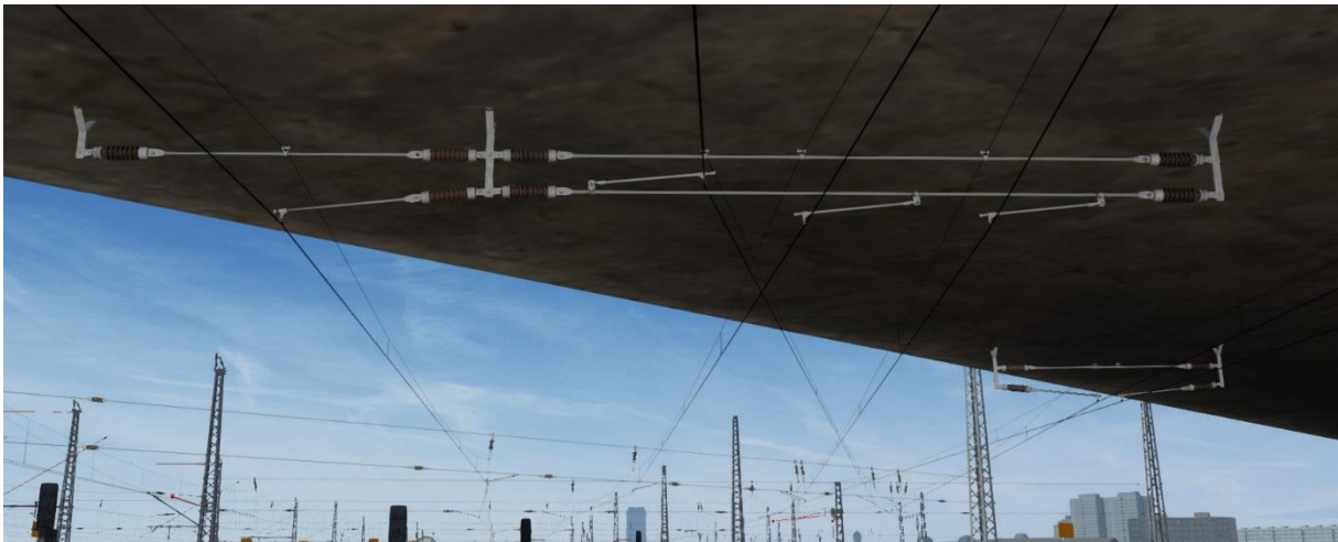
Abbildung 26 - Stützpunkte mit Nachspannung
