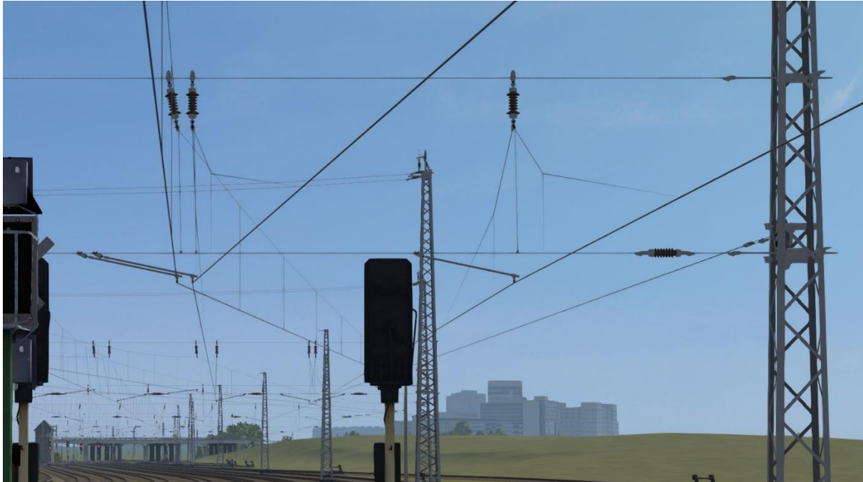
Abbildung 21 - 2-feldrige Nachspannung mit Einfachfahrleitung
