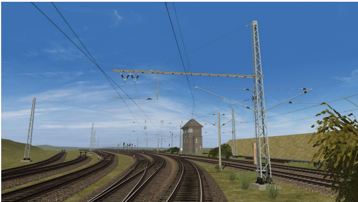
Abbildung 22 - Ausleger über zwei Gleise mit Re1 und Re1 Einfachfahrleitung
