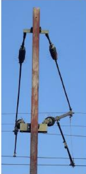
Abbildung 27 - Schrägstellung der Ausleger
