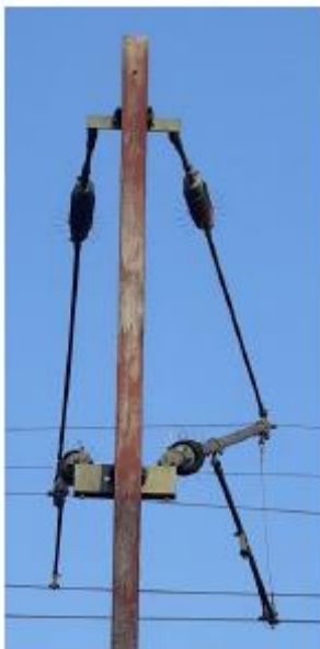
Abbildung 24 - Schrägstellung der Ausleger
