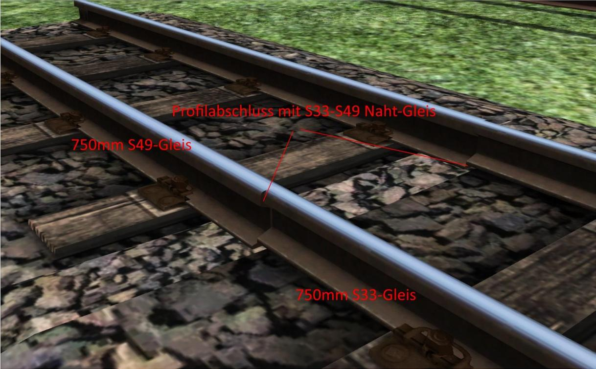
Profilabschluss mit S33-S49 Naht-Gleis
