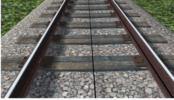
LZB Ausführungen mit Holz und Betonschwelle Endung der Gleise mit „LZB“
