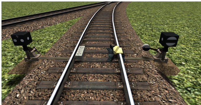
SBS_Gleissperre_R-d Nach rechts entgleisend für handgestellte Gleissperren
