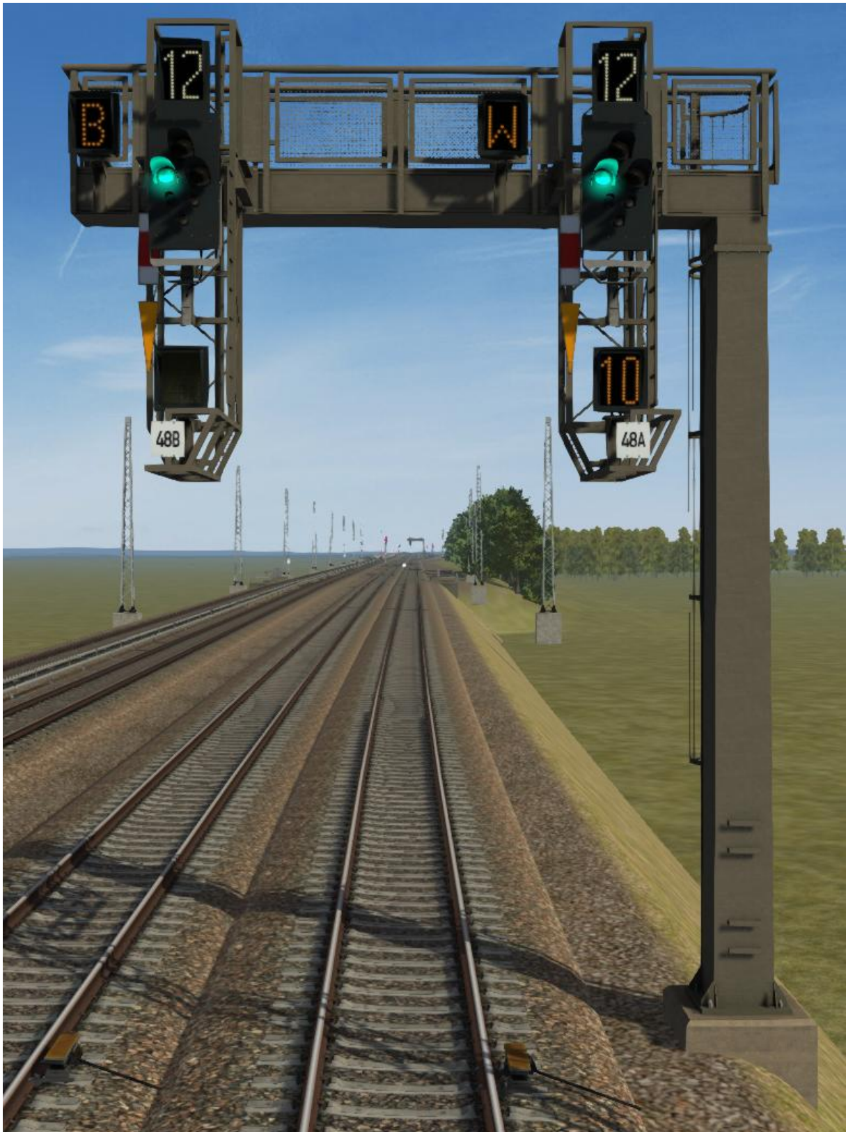
Abbildung 18 - Signalbrücke mit zwei Hauptsignalen (noch ohne Schaltkästen)
