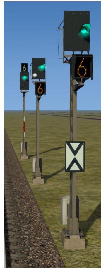
Abbildung 8 - Abfolge von Signalen mit LED Technik
