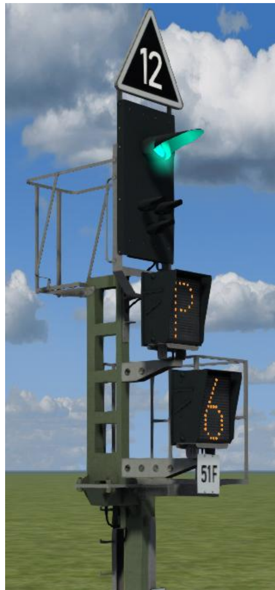
Abbildung 21 - LED-Signal mit Zusatzan- zeigern der neuen Bauform
