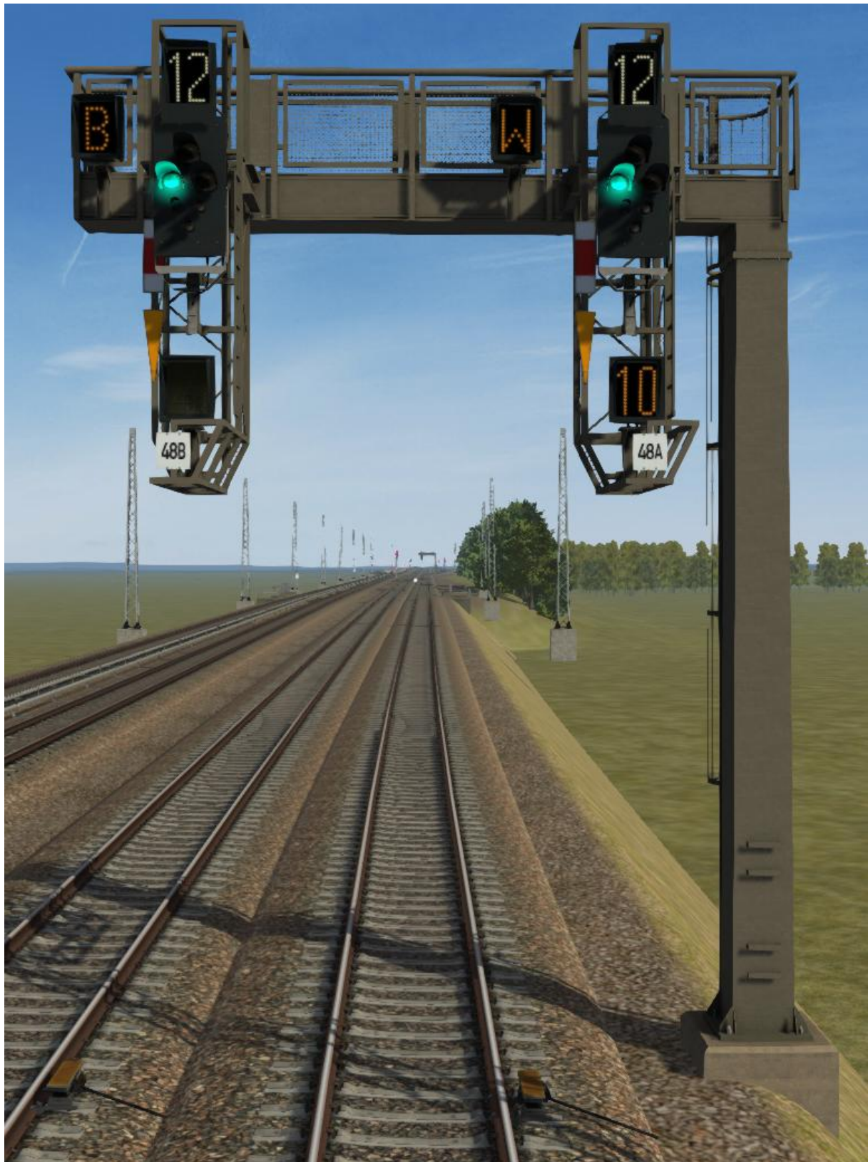
Abbildung 17 - Signalbrücke mit zwei Hauptsignalen (noch ohne Schaltkästen)
