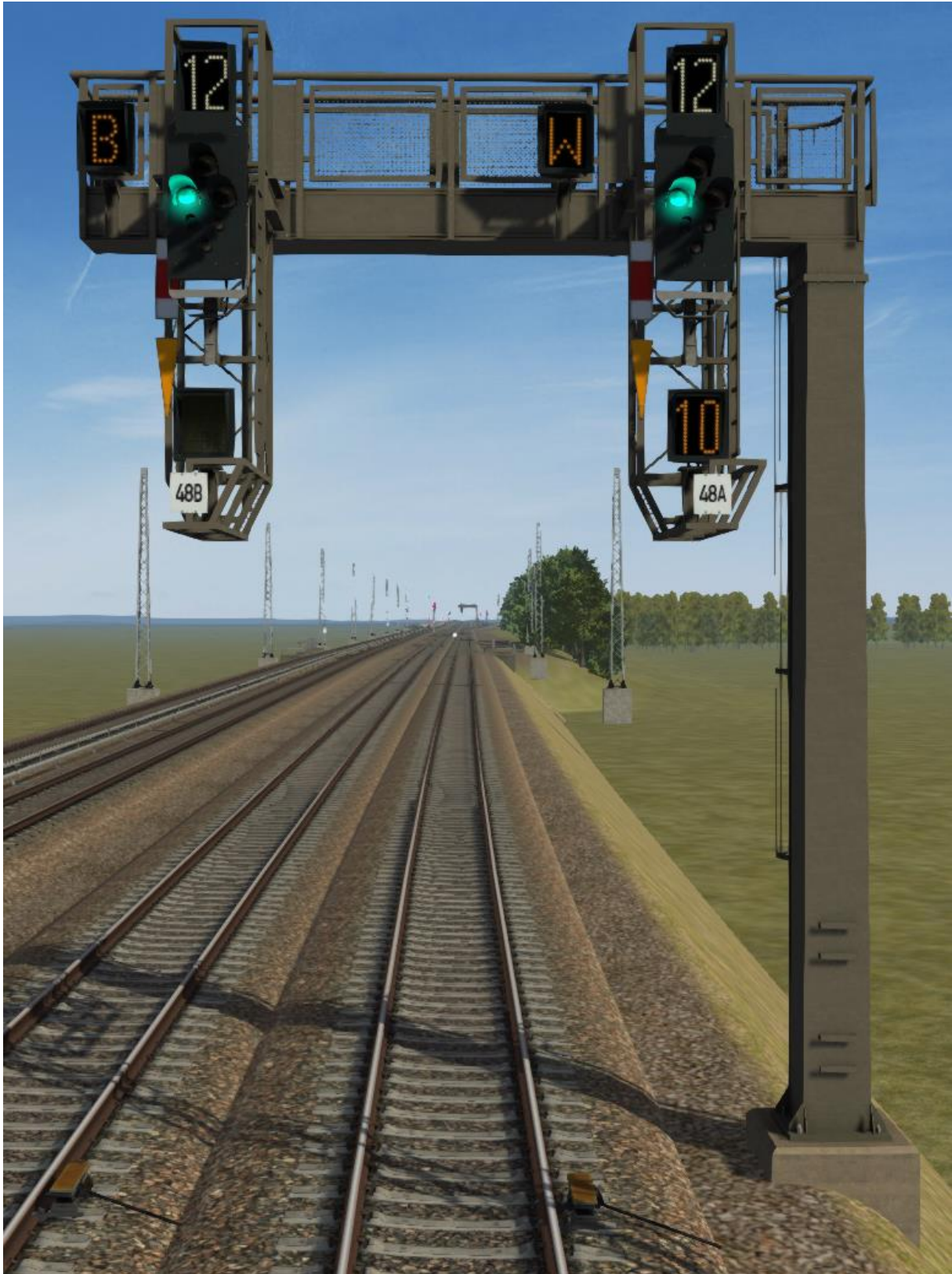
Abbildung 16 - Signalbrücke mit zwei Hauptsignalen (noch ohne Schaltkästen)
