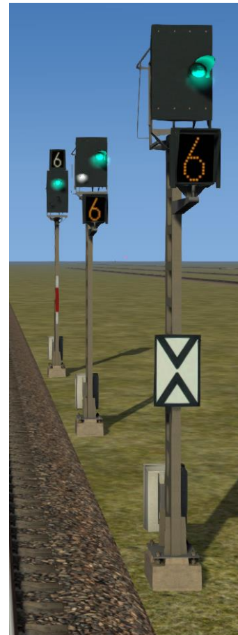
Abbildung 7 - Abfolge von Signalen mit LED Technik
