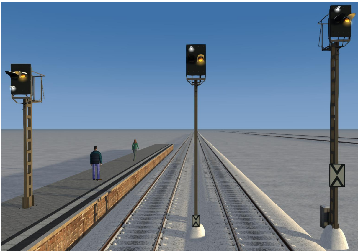
Abbildung 13 - verschiedene gerade Masten im Einsatz
